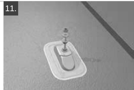
11. Scheiben und Flanschnutter anbringen.
