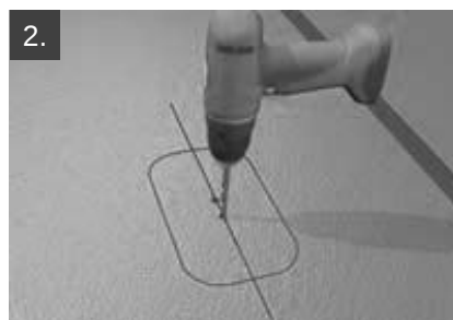
Langloch vorbohren
