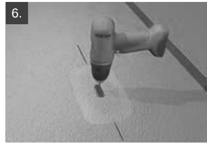
6. Mittig im Langloch vorbohren, Ø 8 mm
